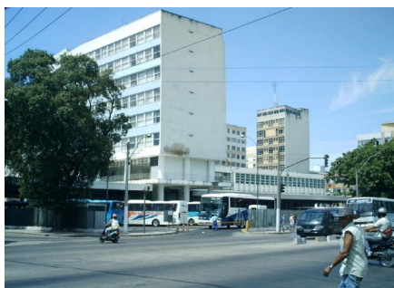
VISTA DA RODOVIÁRIA DE NITERÓI
